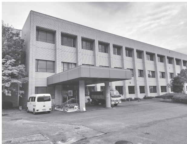
こども園・1階用途変更工事が行われる
