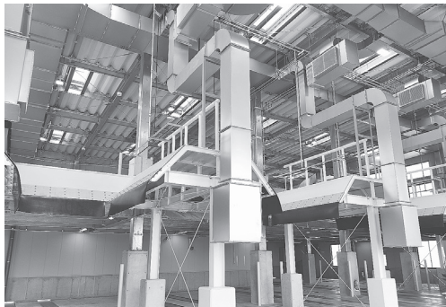
1階 搬出スペース(ごみ受入口)
