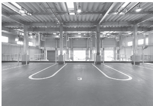
2階 プラットホーム(ごみ投入口)
