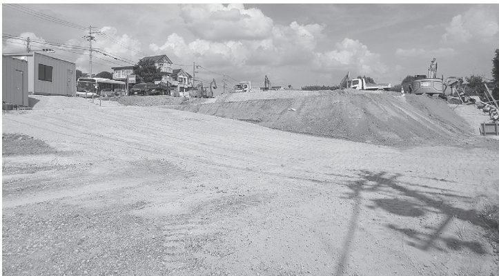
開発工事が進む出店予定地
