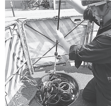
ELIOS3を活用した下水管内調査＝7月4日、奈良市大宮町地内
