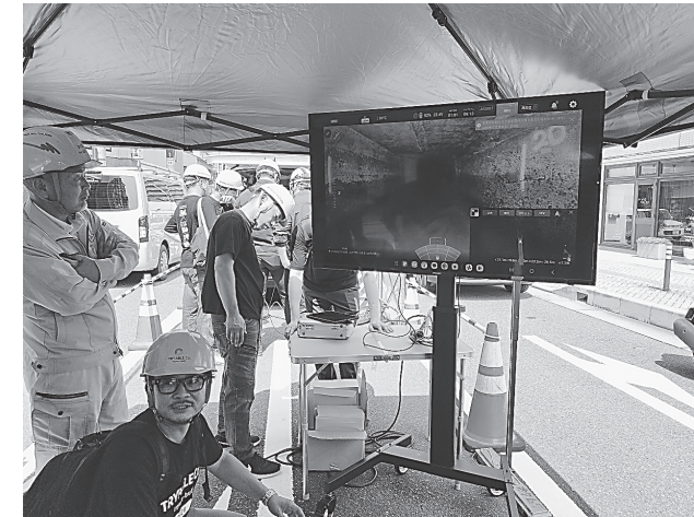
モニターを見ながら管渠内の様子を確認した
