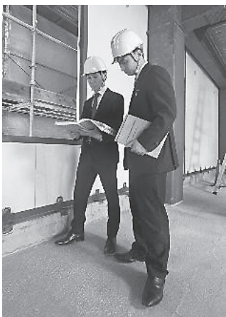
(高田警察署御所警察庁舎改築工事現場)
