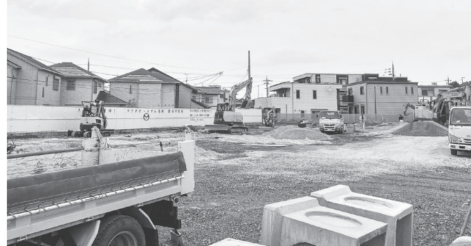
国道165号線沿いに建設
