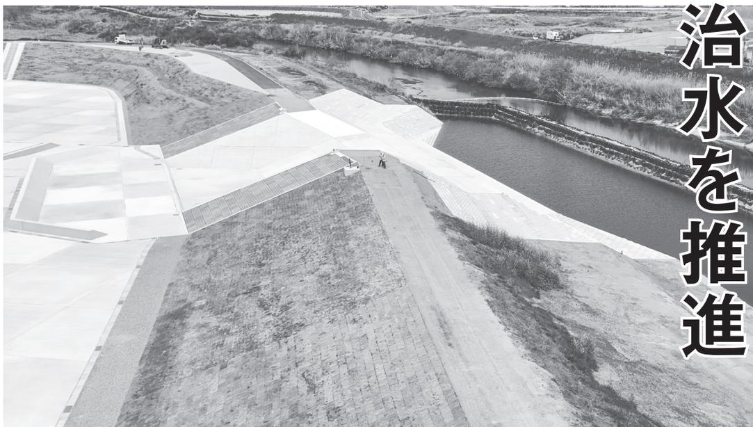
河川(右側)であふれた水を遊水地内(左側)に流す事で浸水被害を抑止する
