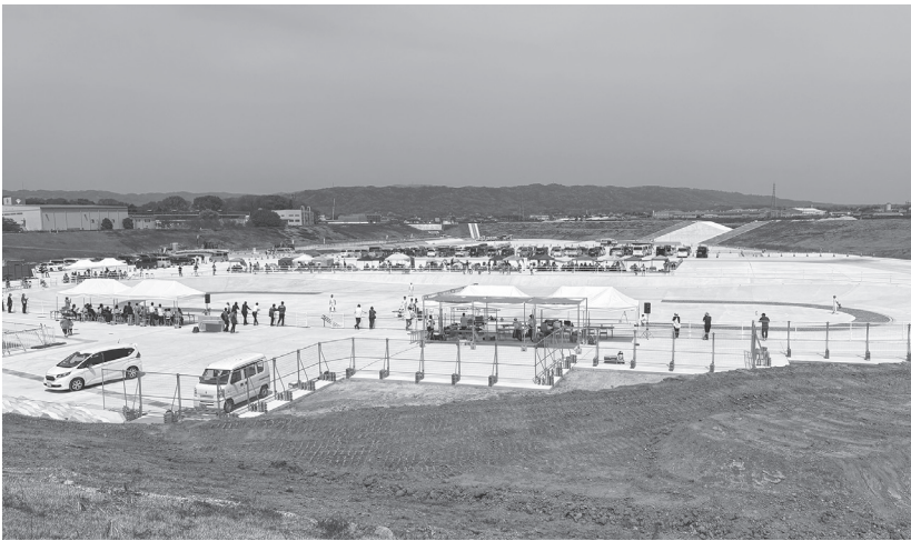
完成したオーバルトラック
