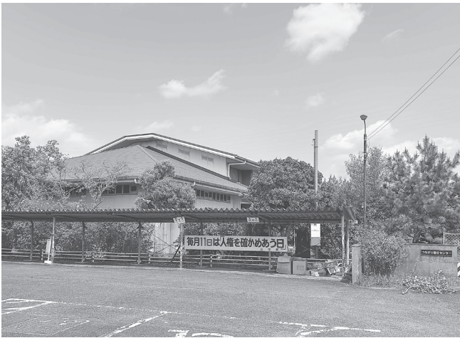
つながり総合センター
