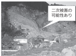
土砂崩落地による災害復旧作業
