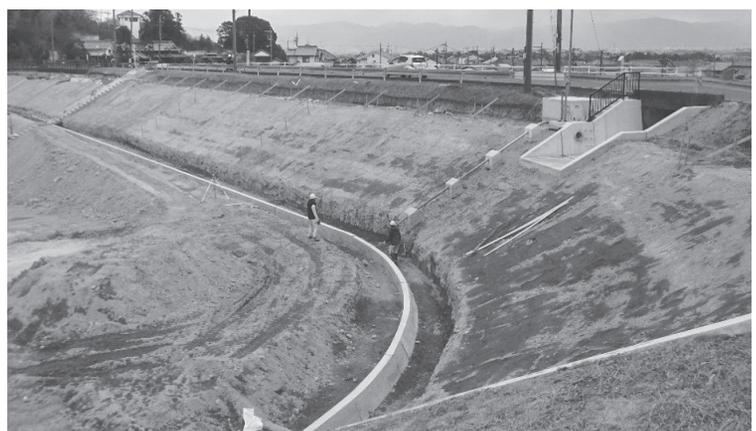
・堤体工L145m、表面遮水工A1635㎡、制波工A1140㎡、構造物撤去工N11式、堤外水路工L101m、仮設工N11式
