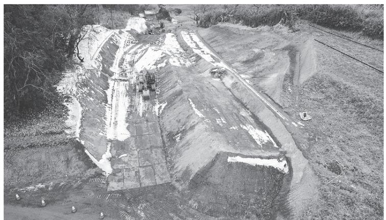
・築道工L260m、土工V1万4500㎡、アンカー工N38本、水路工L84m
