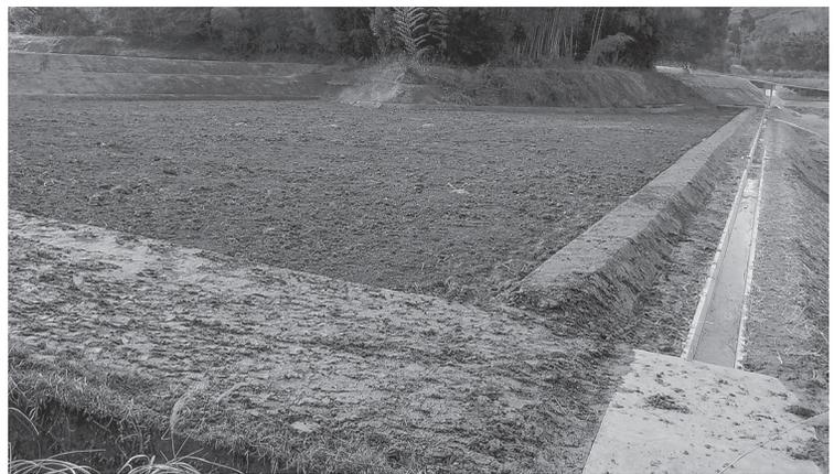
・区画整理工工N11式、整地工A11.02ha、用水路工L27m、用排水路工L117m、道路工L93m
