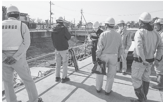
桜井市大泉の現場
