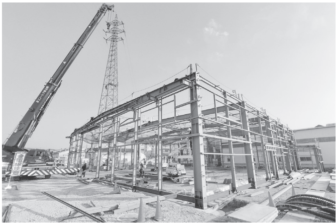
桜井市新屋敷に建設中の新工場＝1月24日撮影
