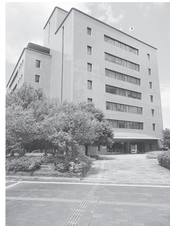
建築後30年以上が経過した
