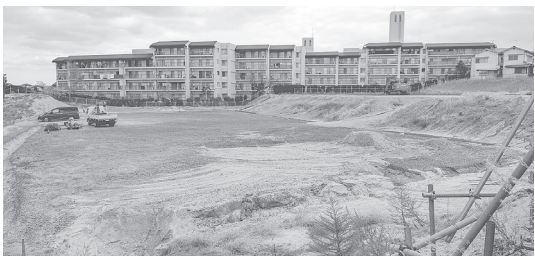
奈良学園朝日元町の建設予定地
