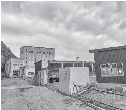
解体撤去する旧ごみ焼却施設(左奥)と建設中のごみ中継施設(手前)
