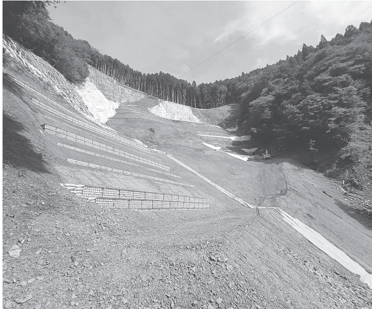
長殿(テラ谷)山腹工事/十津川村長殿
