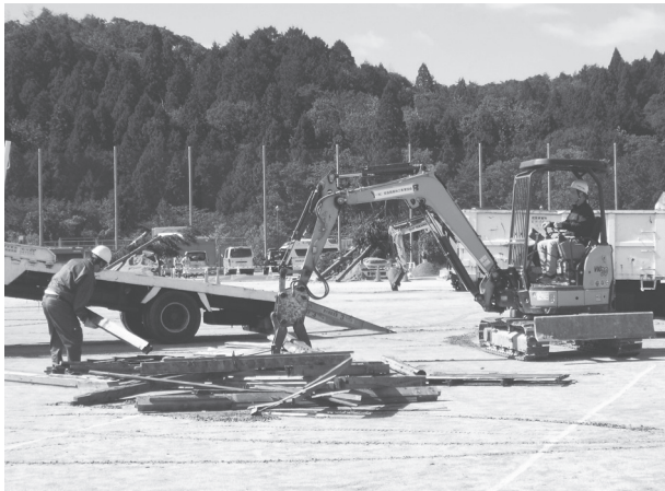
障害物除去を行う奈良県解体工事業協会
