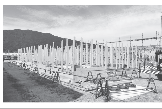
新築中のグループホーム「ヴァイラ」の建設現場。
