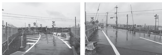
中八条踏切付近
