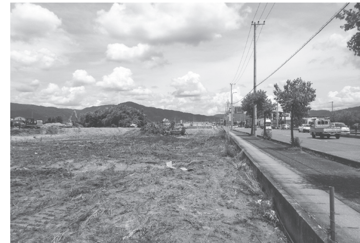
開発工事が進む中和幹線沿いの出店予定地
