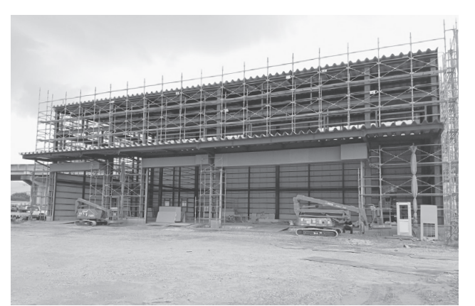
建築工事が進む新工場＝橿原市寺田町50番1
