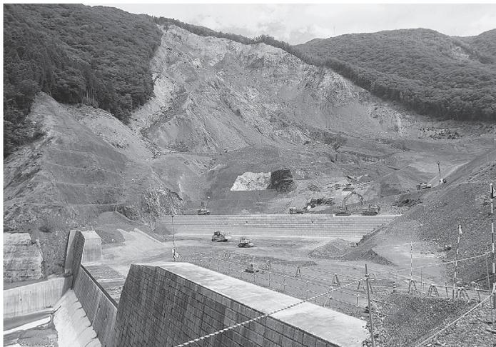
崩落斜面直下での3号砂防堰堤工事の様子
