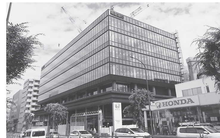
奈良市大宮町4丁目に建設中の南都銀行新本館
