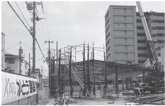
ローソンの建設予定地 (大和高田市西三倉堂)
