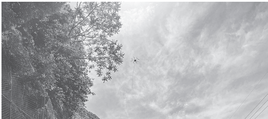
T5Aドローンによる資材運搬状況
