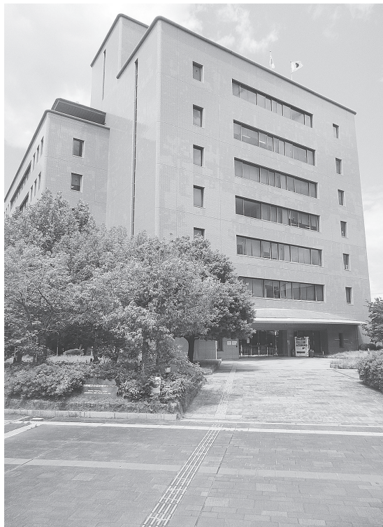
建築後30年以上が経過した
