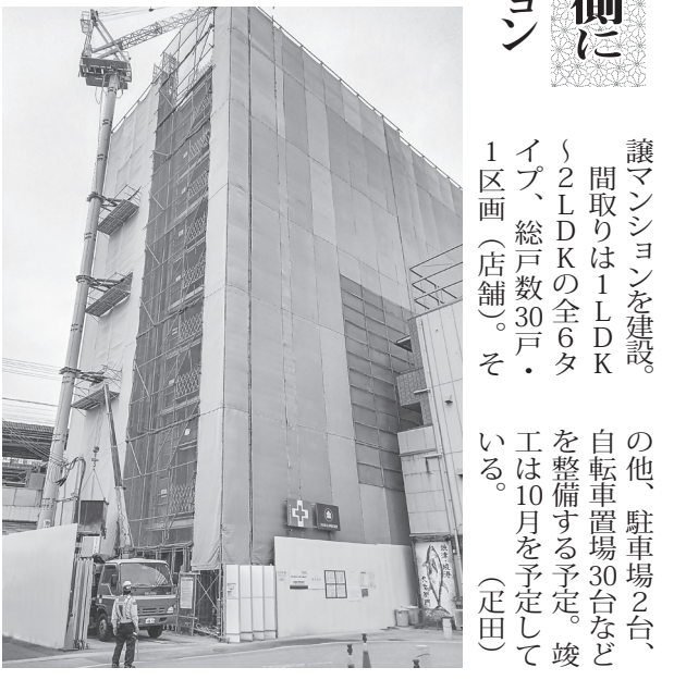
建設中の近鉄大阪線・橿原線「大和八木」駅南側にローレルアイ大和八木分譲マンションのRC9階建て、総戸数30戸十店舗の建物。
