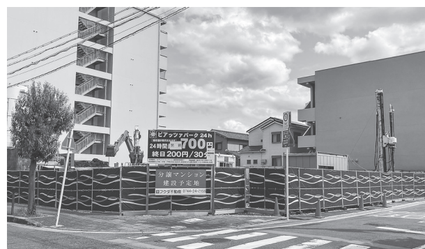
「ピアッツアレジデンス樫原神宮前駅」建設予定地
