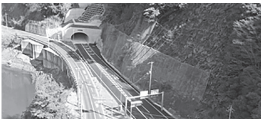
トンネル南坑口(小代側)
