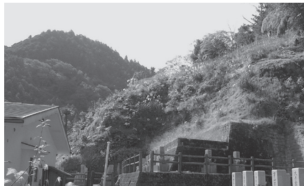
主要地方道吉野室生寺針線 緑川橋橋梁補修工事
