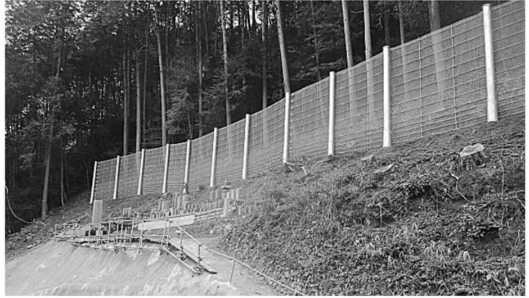
・工事延長L||80m、崩壊土砂防止柵工L||47m、コンクリート吹付A||142m<sup>2</sup>
