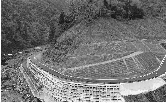
・工事延長L||475m、吹付法砕工(600mmA||127m、300mmA||166m、200mmA||115m)、グラウトアンカー工N||14本、鉄筋挿入工N||46本、場所打擁壁工(重力式)V||162m、側溝工L||321m、掘削工(ICT)V||53000m<sup>3</sup>盛土工(ICT)V||54000m<sup>3</sup>、植生工A||20800m<sup>2</sup>、下層路盤工A||24100m<sup>2</sup>
