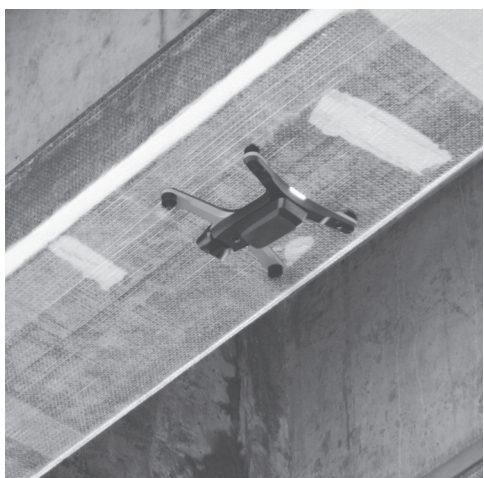
大川橋の点検を実演するドローン
