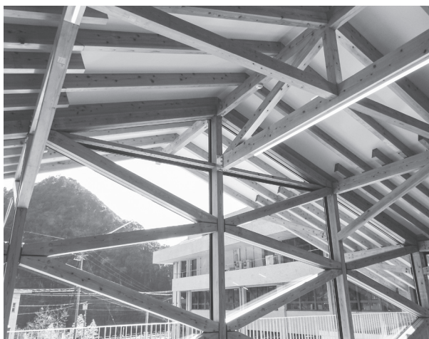
耐震性を高めた木造軸組構造を採用
