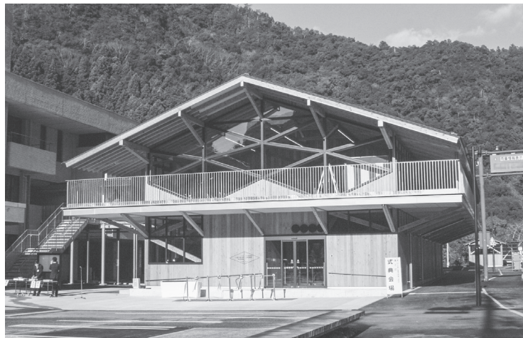
十津川村災害対策本部拠点施設
