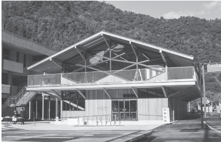
十津川村災害対策本部拠点施設
