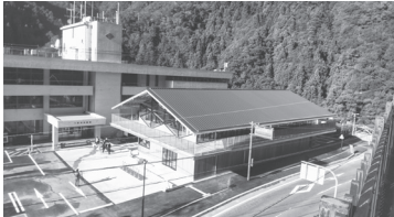
本庁舎とは別棟で建設
