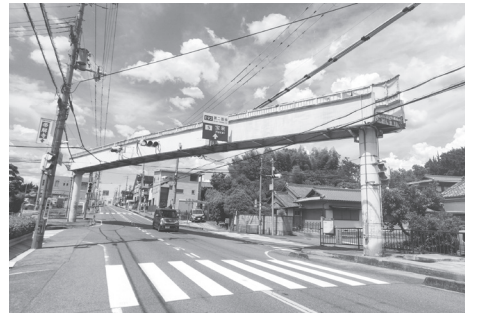
役目を終えた歩道橋の撤去なども進めている
