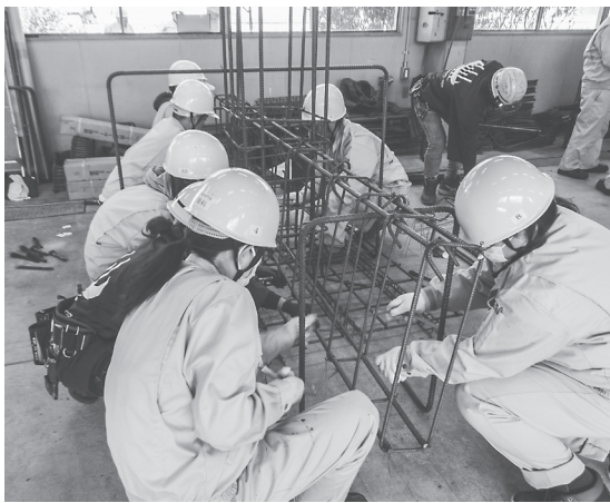
鉄筋で柱と梁を組み立てる様子
