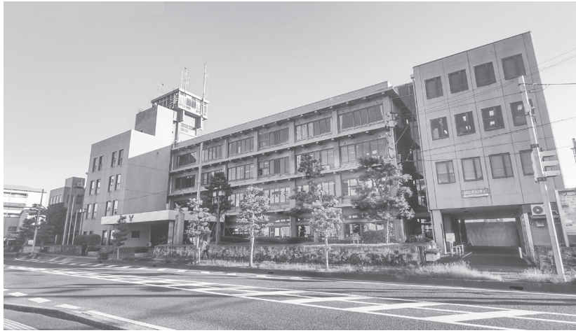
解体の準備が進んでいる現庁舎
