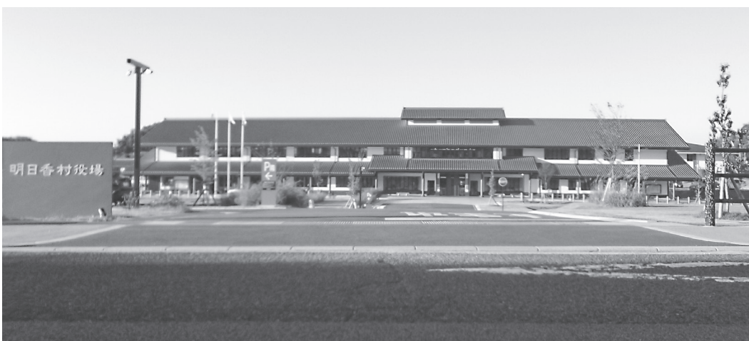
移転新築し利便性を高めた新庁舎
