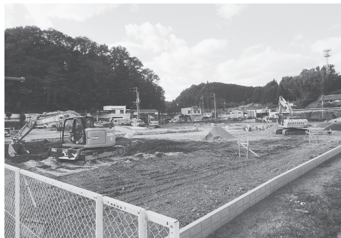
開発工事が進む出店予定地
