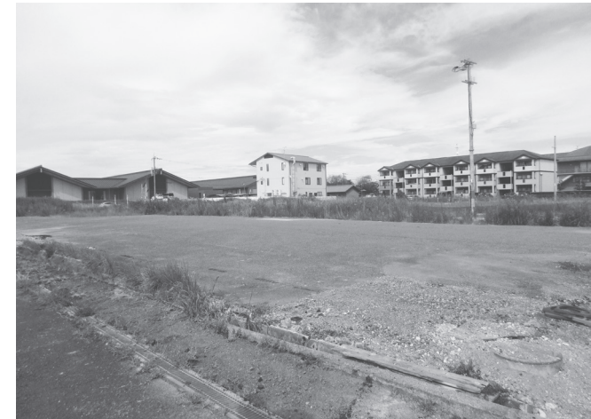
整備予定地の現況
