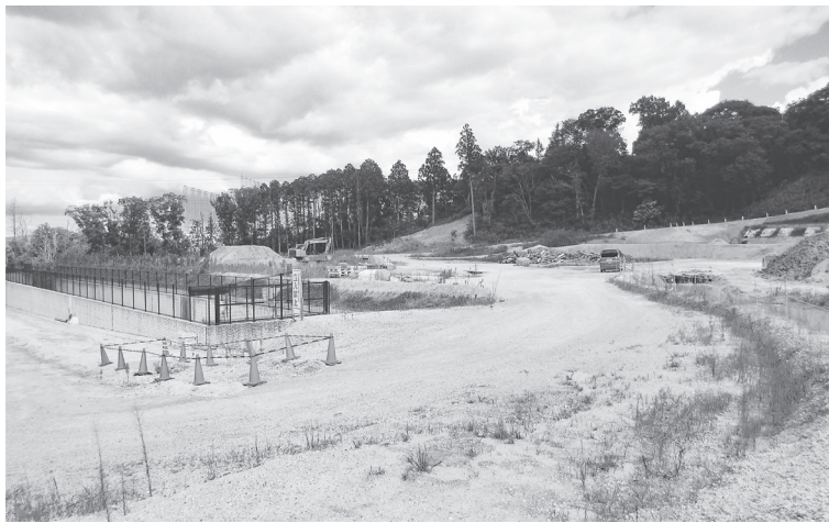
造成が進む建設予定地周辺
