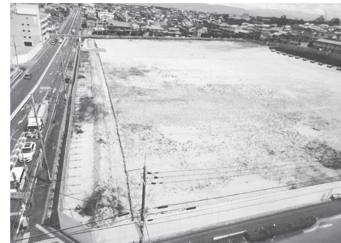
旧施設の解体を終えた出店予定地
