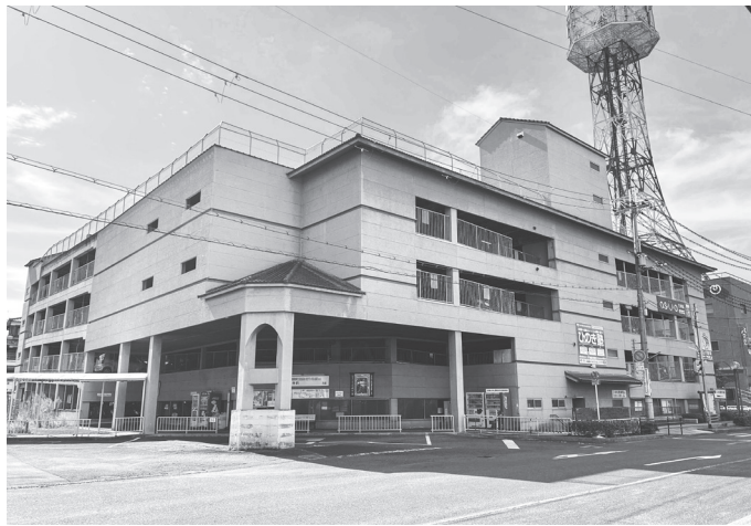
耐震性の問題で撤去される三の丸駐車場
