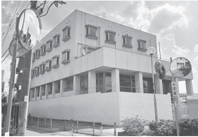
解体される王寺町中央公民館
