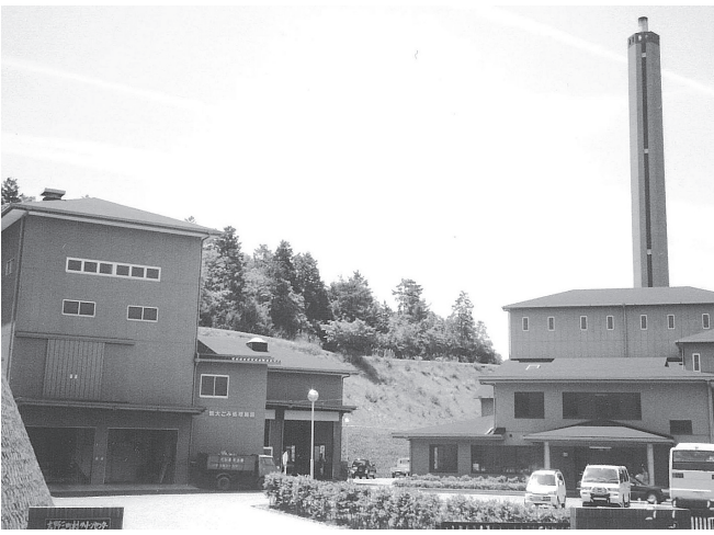
平成29年3月に稼働を停止しているクリーンC可燃棟
