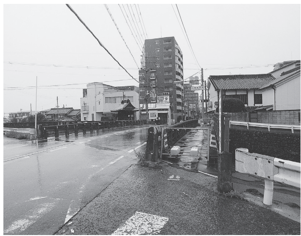
現在の磐余橋(側歩道橋)
