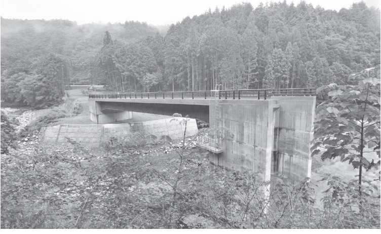
土工部の整備を待つ「1号橋」
