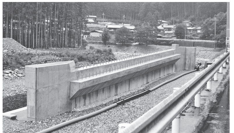
2号橋A2橋台、対岸にA1橋台の整備を予定している
