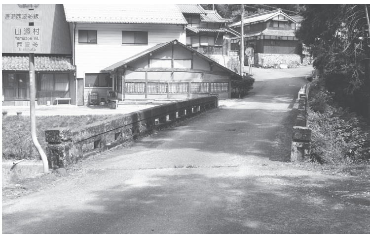
整備を予定する大門橋
