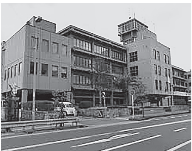
本館・西棟・西館を解体
