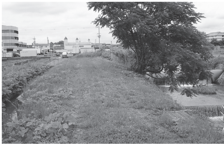
堤体強化のため舗装が施される
