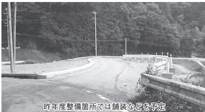
施工予定箇所
