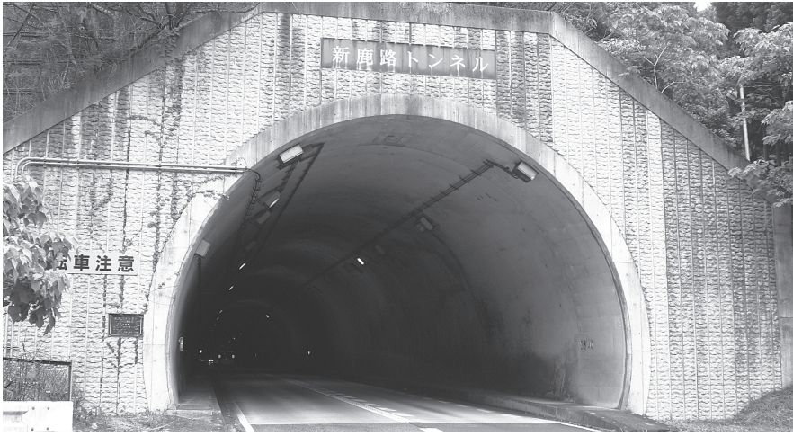
新鹿路トンネル
