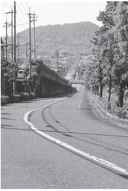
舗装の更新を予定する見瀬五井線
