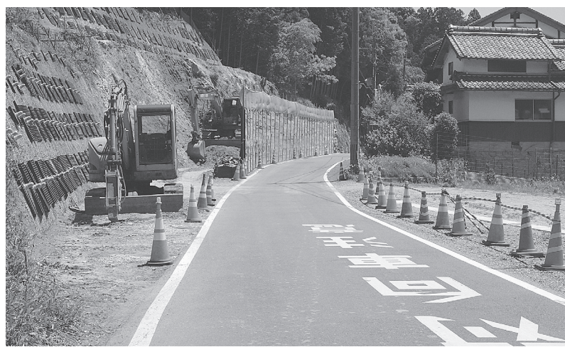
現在、法面対策工事を進めている
