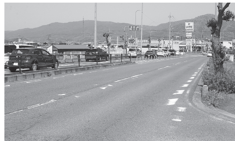
舗装工事を予定する「中和幹線」西向き車線
