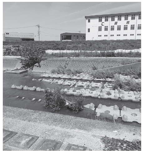
護床ブロックの沈下が伺える
