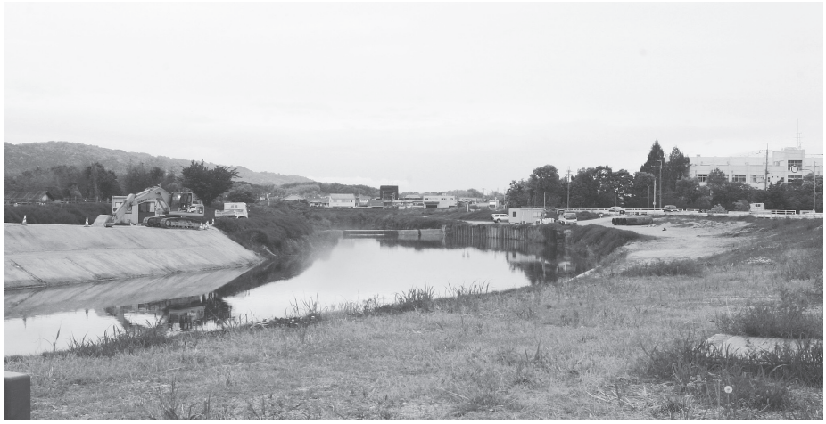
護岸工事が予定される富雄川(斑鳩町高安)
