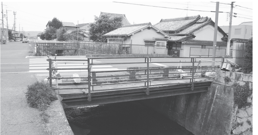
側道橋の補修が予定される(奈良市横井町)
